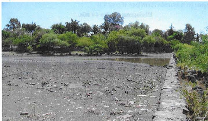
Figura 3.2. Bordo San Miguelito completamente azolvado, contaminado y no funcional para el control de avenidas en la Cuenca Urbana de la Zona Metropolitana de Querétaro.
